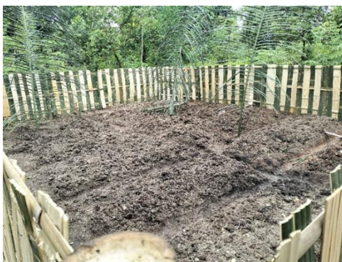
Gambar 4. Pemasangan Pagar Tanaman
